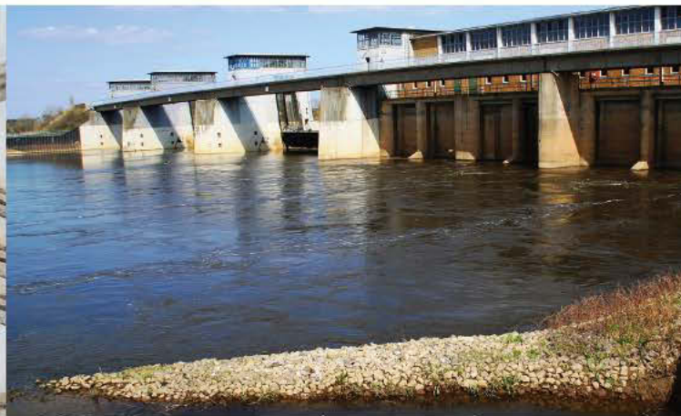
Wasserkraftanlagen und Stauwehre beeinträchtigen Aalwanderungen
